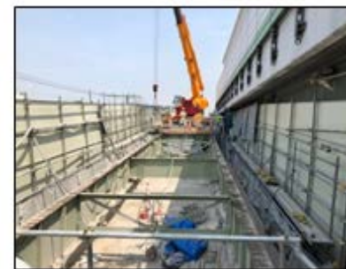
損傷した RC 床版の撤去
