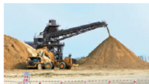
土砂運搬用ベルトコンベヤー（茨城県市野原北部丘陵地区）
