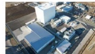
苫小牧市のバイオマス発電所 (2025年5月運用予定)
