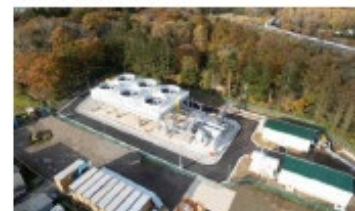
森町の地熱バイナリー発電所 (2023年11月運用)
