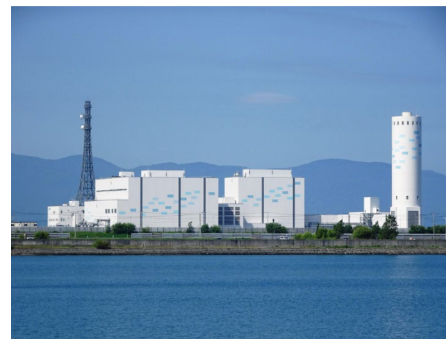
石狩湾新港発電所
