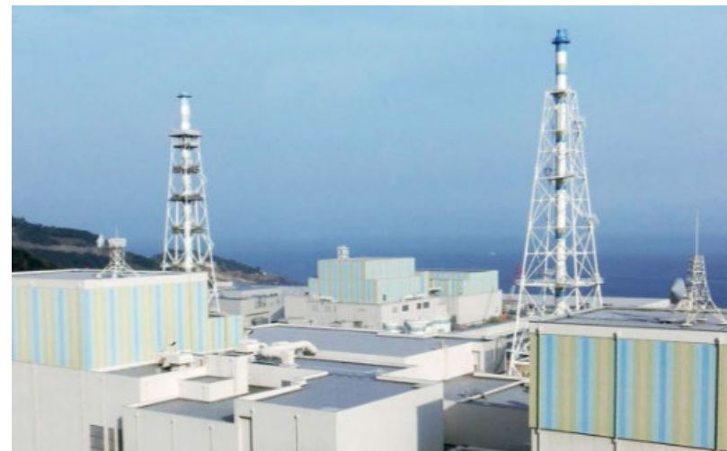
島根原子力発電所
