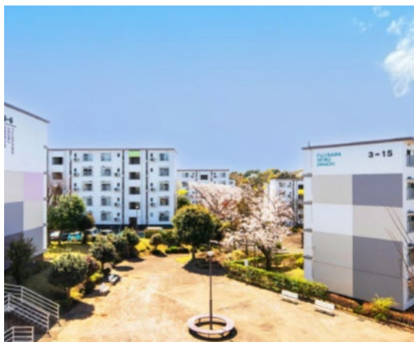
外壁塗装後の藤沢西部団地
