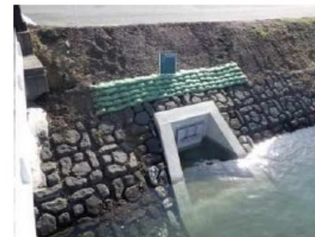
河川の護岸改修による浸水被害の軽減
