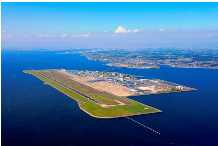
空港島全体を南西から
